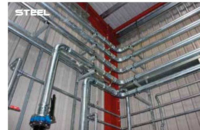
Installationsbeispiele von PCC Pressverbindern / Installation examples for PCC press fittings
